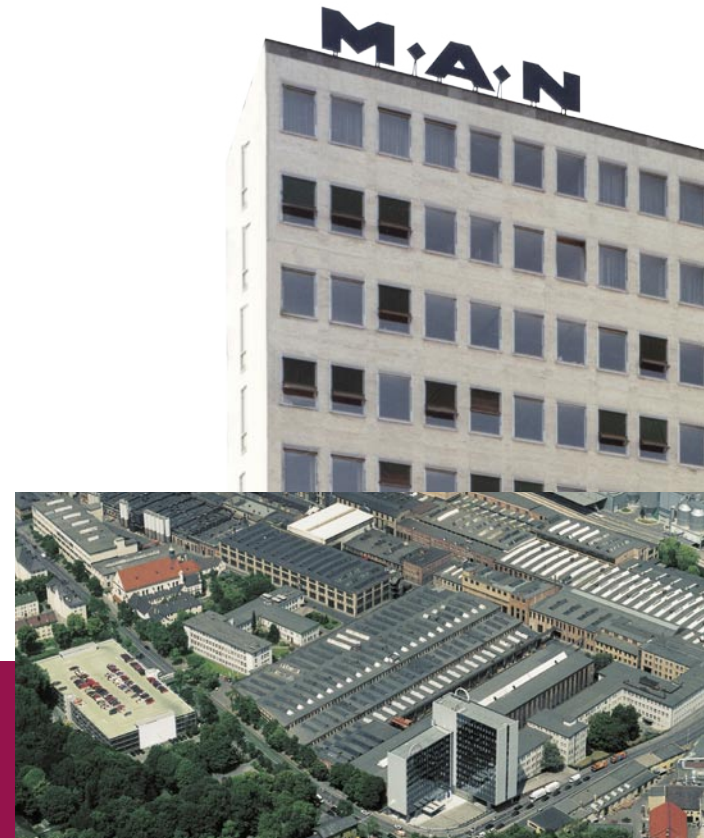
Augsburg: M.A.N.-Hochhaus gestern, Werksgelände heute
